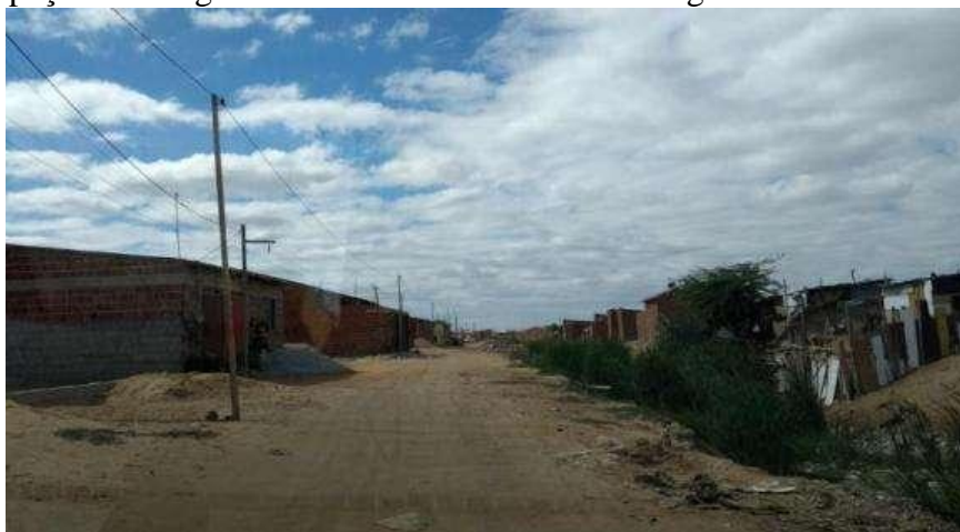
Fig. 06: Ocupação às margens de canal de escoamento de esgoto no bairro Jardim Amazonas
