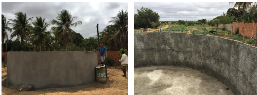
Fig. 11 e Fig. 12: Reservatório pulmão construído na Horta Povo Unido
