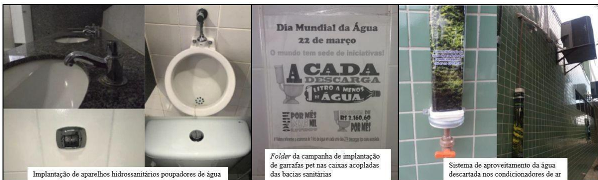
Fig. 2 Exemplos de ações de uso racional da água implementadas na Universidade Federal Rural do Semi-Árido
